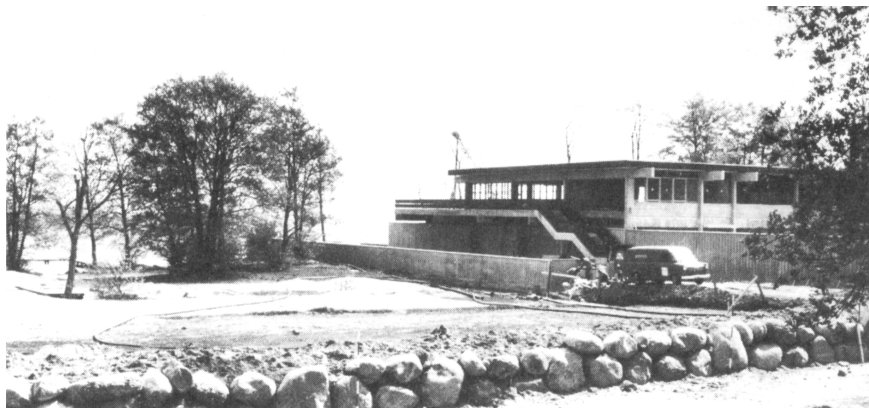
Det nye Furesøbad under opførelse i 1972
